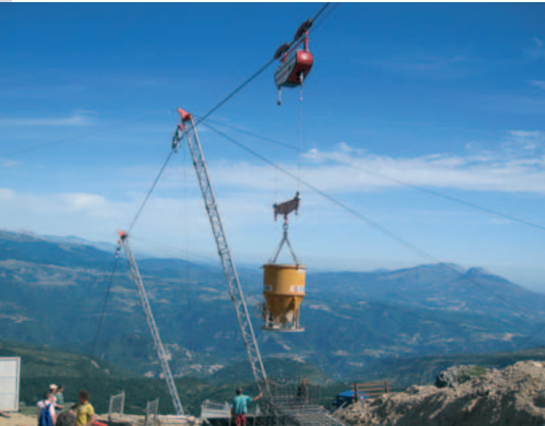
Transport von 1,5 m 3 Fertigbeton
